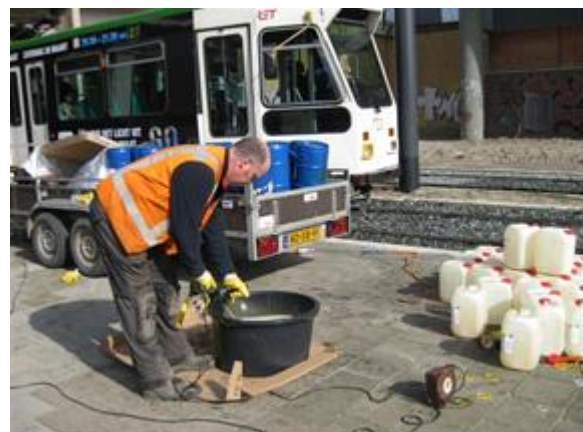
4. Mengen van PUR met harder
