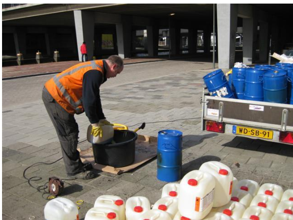
3. De harder aan PUR toevoegen
