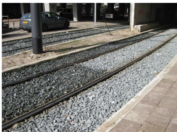
6 – Eindresultaat verstevigd ballast
