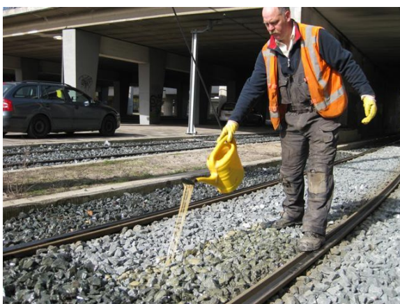
5. Mengsel met gieter verdelen over ballast
