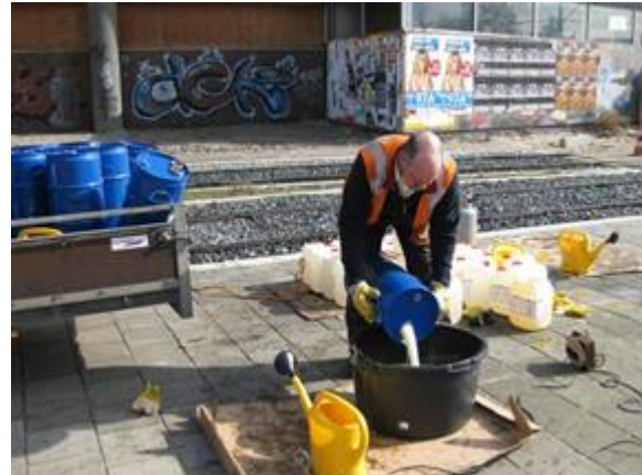
2. Na opwarming PUR in mengbak gieten
